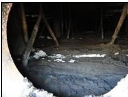
Figura 12. Reator drenado, espuma e lodo residual
