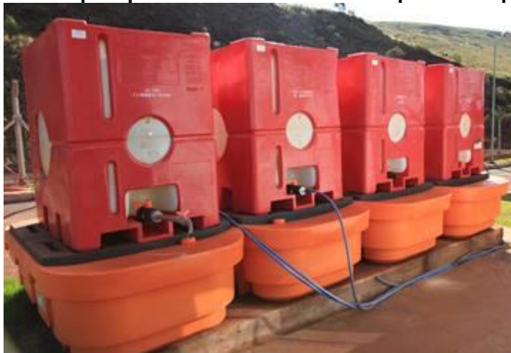
Figura 7 – Tanques para acondicionamento de produtos químicos.
