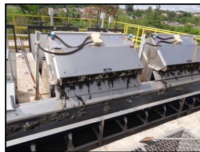
Figura 14. Resíduo removido nas peneiras
