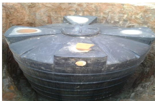
Figura 2 – Fossas sépticas - modelo EMATER instaladas na comunidade de Ribeirão do Eixo
