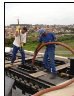
Figura 5. Limpeza de espuma com caminhão esgota fossa
