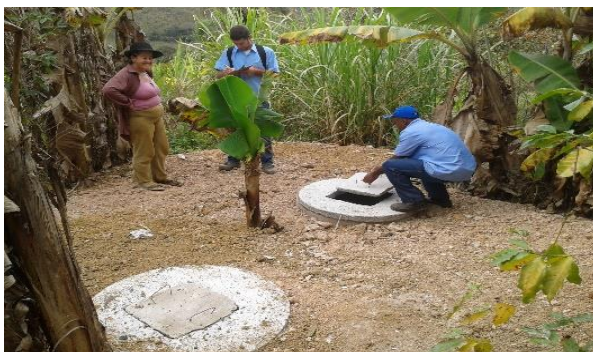
Figura 2 – Fossas sépticas - modelo EMATER instaladas na comunidade de Ribeirão do Eixo
