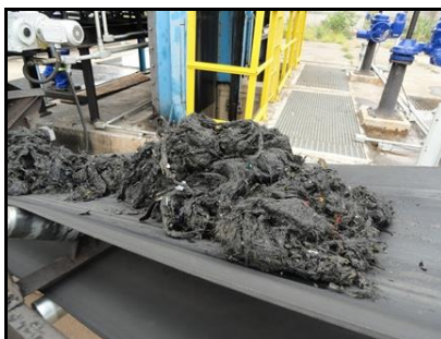
Figura 13. Resíduo removido no Gradeamento Grosso
