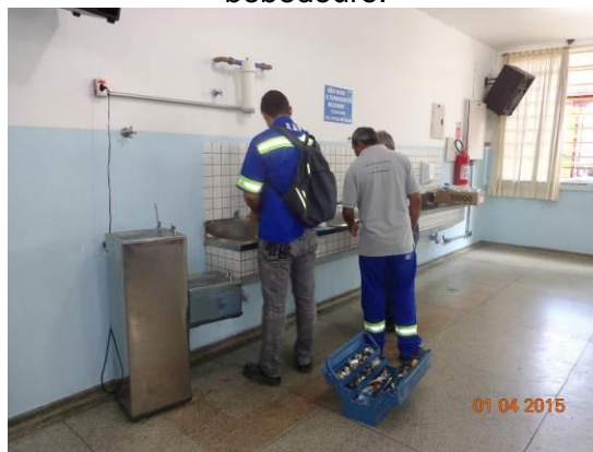
Foto 8 – Substituição de torneira de bebedouro.
