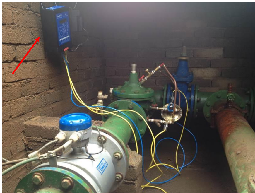
Figura 09 - DMC Manfrini com macromedidor eletromagnético, VRP e modulador
