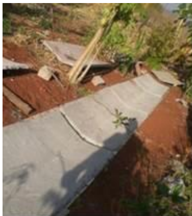
Figura 5 – Concretagem das laterais da cisterna
