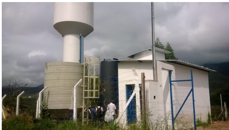
Figura 1 – ETA construída na comunidade de Ribeirão do Eixo.
