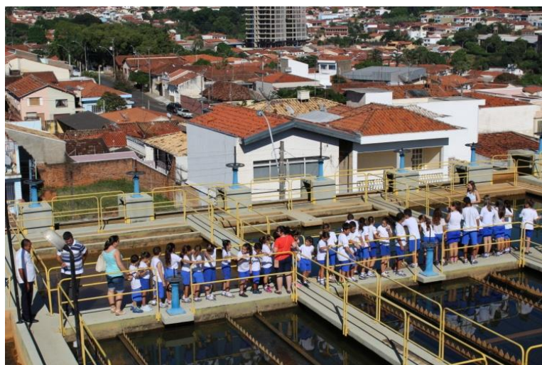
Figura 7 – Visita realizada na ETA
