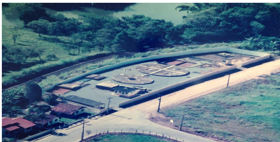
Figura 1 - Estação de Tratamento de Esgoto Sanitário Nereu Ramos, Jaraguá do Sul- SC.
